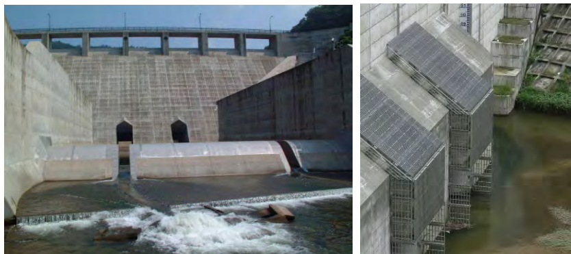
下流側から見た益田川ダム(左)と、 穴の上流側を覆うスクリーン(柵)
