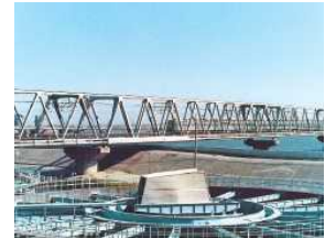
南砂町浄水場
