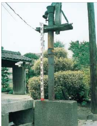
地盤沈下により抜け上がった井戸 (足立区青井・平成4年)
