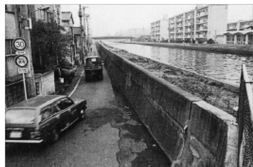
水面より下の道路 (江東区北砂・昭和50年)
