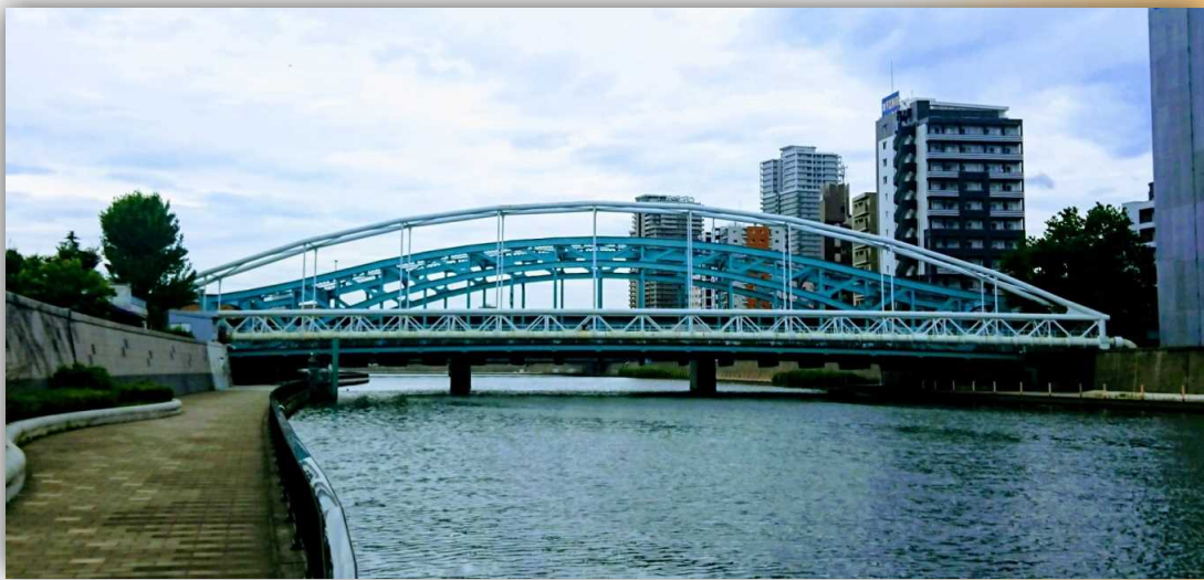
千住水管橋 (隅田川 荒川区南千住六丁目から足立区千住橋戸町間)
