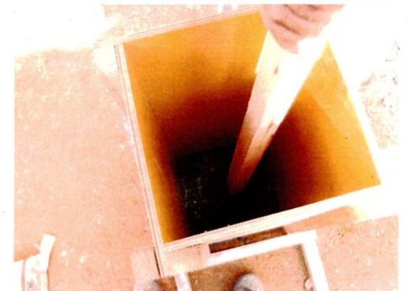
敷モルタル打設
