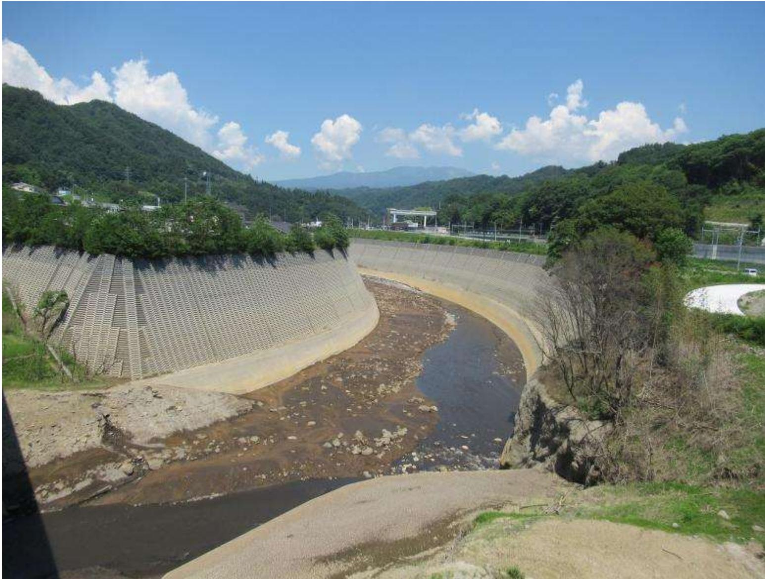
ハツ場ダムはダム完成前の2019年10月に襲来した東日本台風の影響で、ダム完成1年後の時点（2021年3月末）で300万 $\text{m}^3$ （堆砂容量の17%）の土砂が堆積
