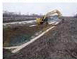
河道掘削 (石狩川水系、北海道開発局)
