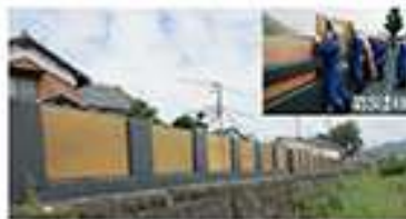
自主防災活動による費堤設置 (桂保川水系、たつの市)
