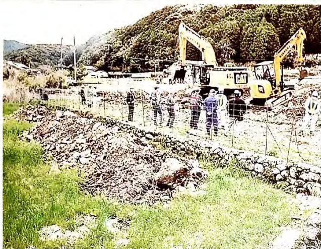
土砂が搬入された耕作地(手前)。撤去された柵を反対住民が設置し直し、隣接地で工事を続ける県側に抗議を続けた
