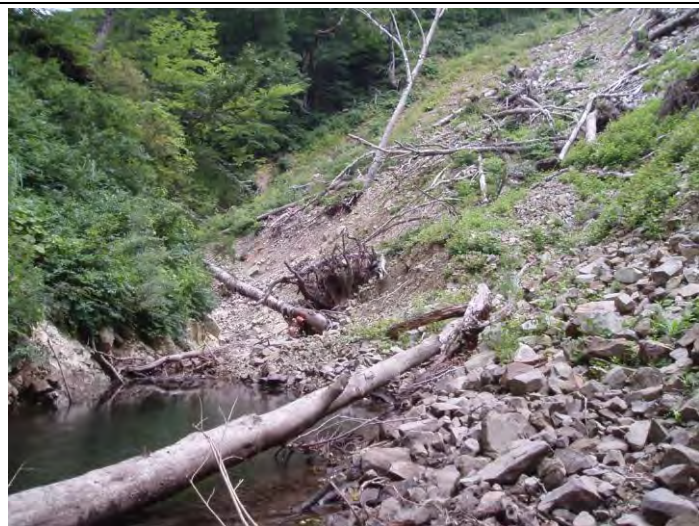
沢が完全に埋まっている（下流側を見る）
