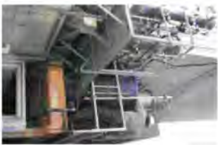
ホテル棟に設置されている地下水のろ過設備＝神戸市中央区、ホテルサンルートホテル神戸
