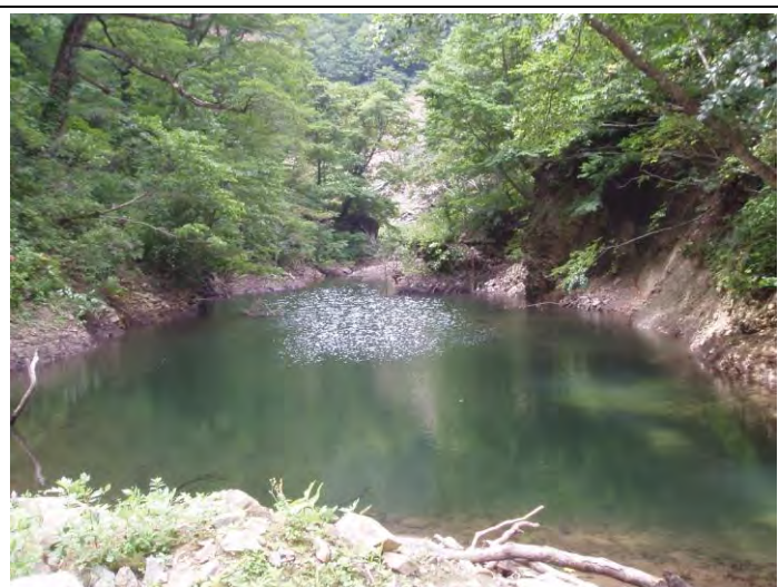
堰き止め湖を形成している
