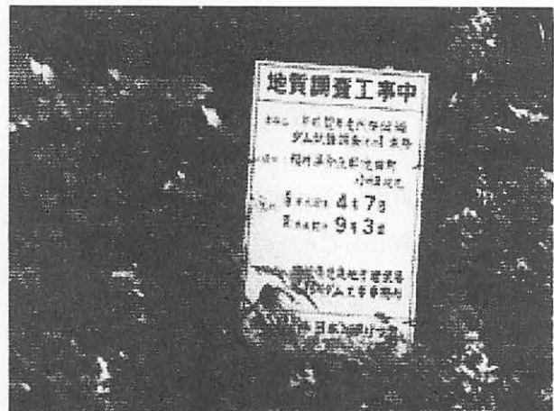
部子川右岸のボーリング調査
