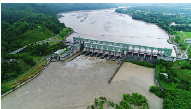
【2018年7月4日：二風谷ダムの堆砂域は土砂で埋まっている】
