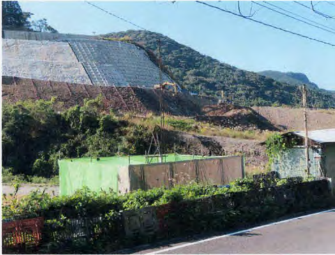
団結小屋裏の地質調査用ボーリングヤグラ(手前) と本体左岸側法面工事(奥) (2023.11.02 の状況)
