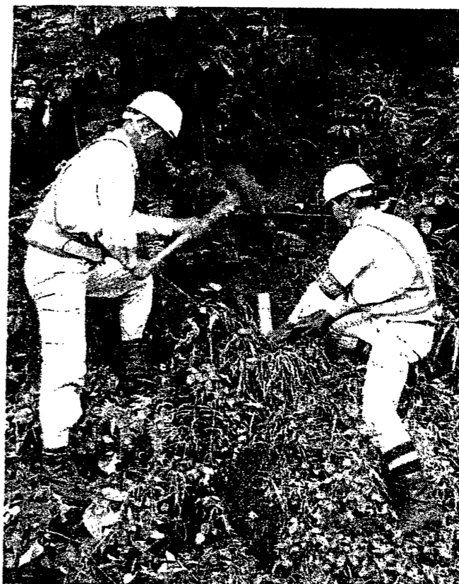
山鳥坂ダムの貯水域を確定する杭を設置する作業員＝3日午前、大洲市肱川町山鳥坂
