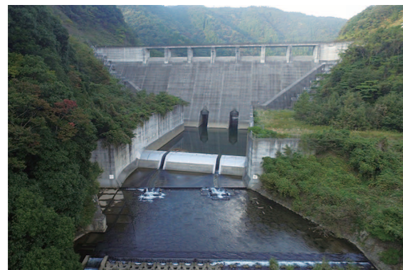
既設の流水型ダムは益田川ダム、辰巳ダム、西之谷ダム、浅川ダム、最上小国川ダムです。 左の写真は島根県の益田川ダムで、完成している流水型ダムの中では現在日本最大規模のダムです。 写真出典●益田川ダム画像 -Bingimages 最上小国川の観察報告も参照してください。 https://tinyurl.com/ytzet7yv
