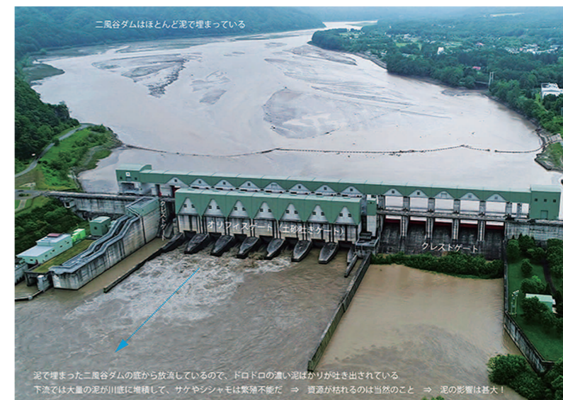
二風谷ダム：ドロドロの濃い泥ばかりが吐き出されている。
