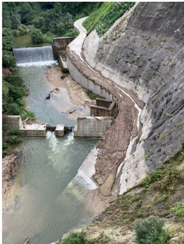
写真3 湛水時にダム湖底に堆積・沈殿した泥
