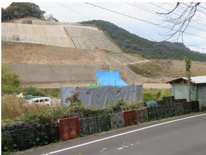
団結小屋裏の地質調査用ボーリングヤグラ(手前)と本体左岸側法面工事(奥) (2024.12.09 の状況)
