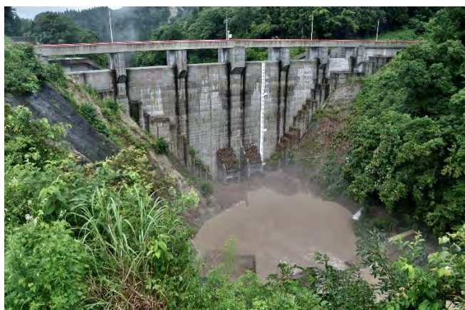
写真 2 7 月 25~26 日の豪雨後の最上小国川ダム
