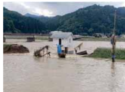
②球磨川右岸堤防の決壊 (56 k 400 付近)
